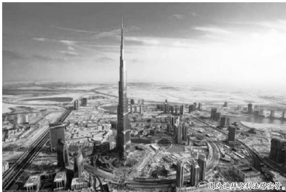
图为迪拜哈利法塔塔架。
